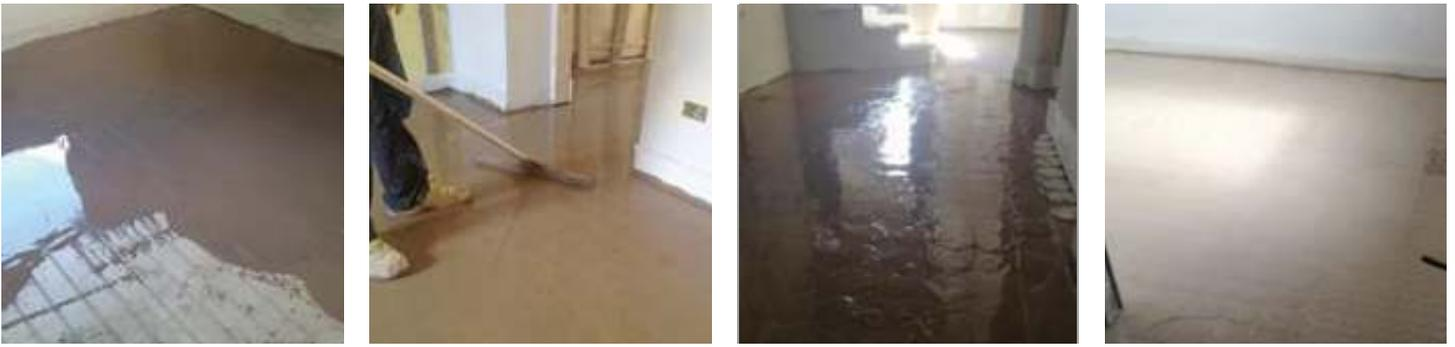
Dopo 48 ore si può stendere il riempimento ed effettuare il livellamento in spessore minimo di 3 mm sopra i bugni. Lo spessore massimo del massetto realizzabile è 15 mm.
